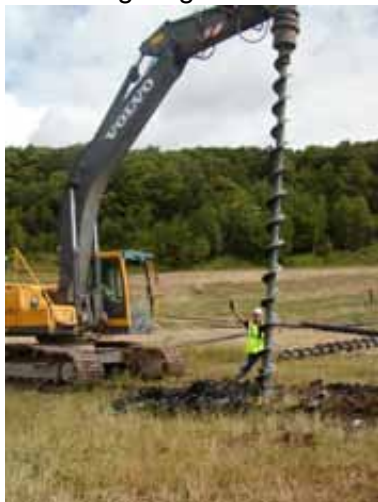
Exemple de forage d'un puit de biogaz
