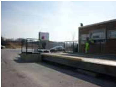
Photo 12 – Guide-roues du pont-bascule
