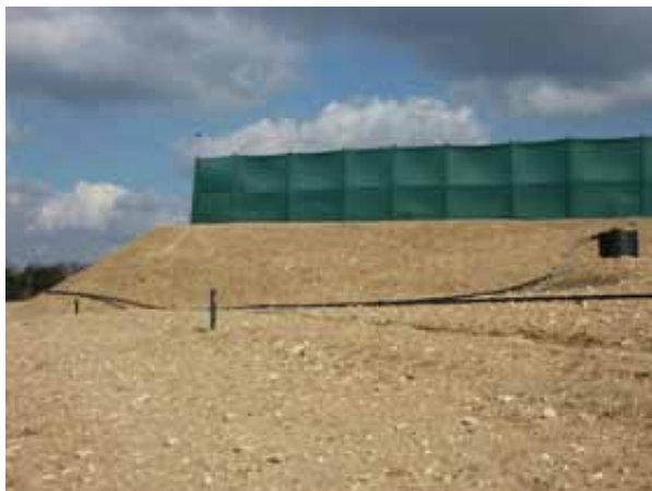
Photo 11 – Réaménagement du casier 9B et prolongement du réseau de dégazage jusqu'à la périphérie du C9C
