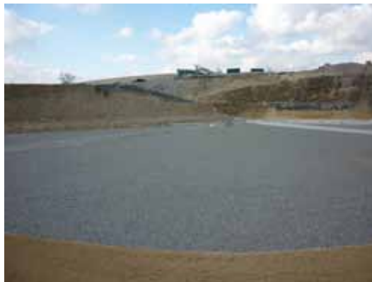
Photo 9 – Nouvelle alvéole 9D
