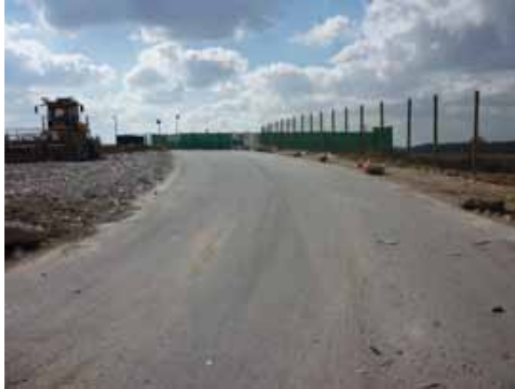
Photo 10 – Piste d'accès au quai n°3
